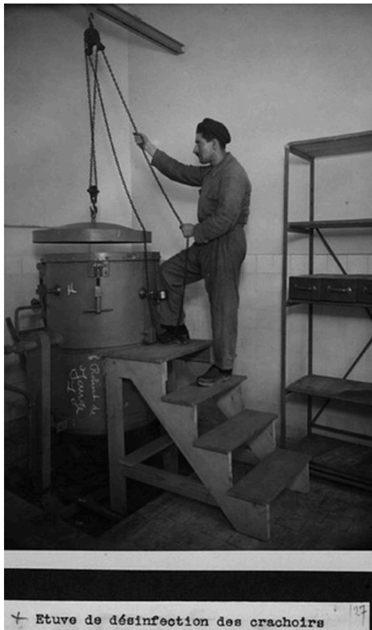
Etuve de désinfection des crachoirs. Photogr., vers 1960
