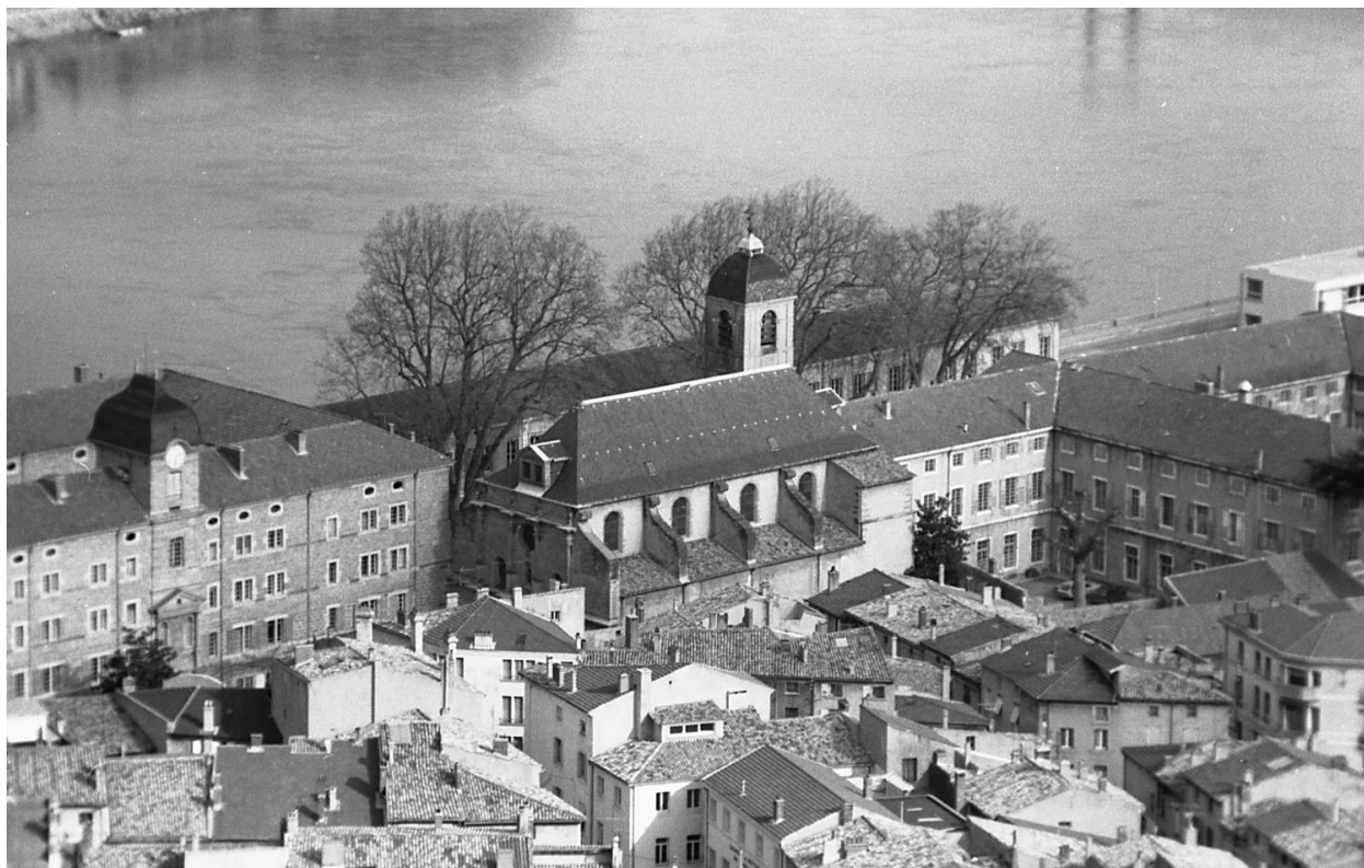
Vue générale depuis le nord-ouest, v. 1976 (AP Plantin)
