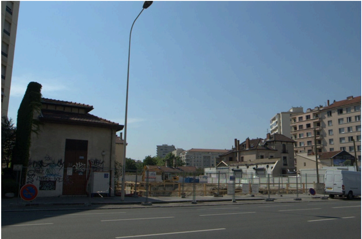
Vue ouest après démolition
