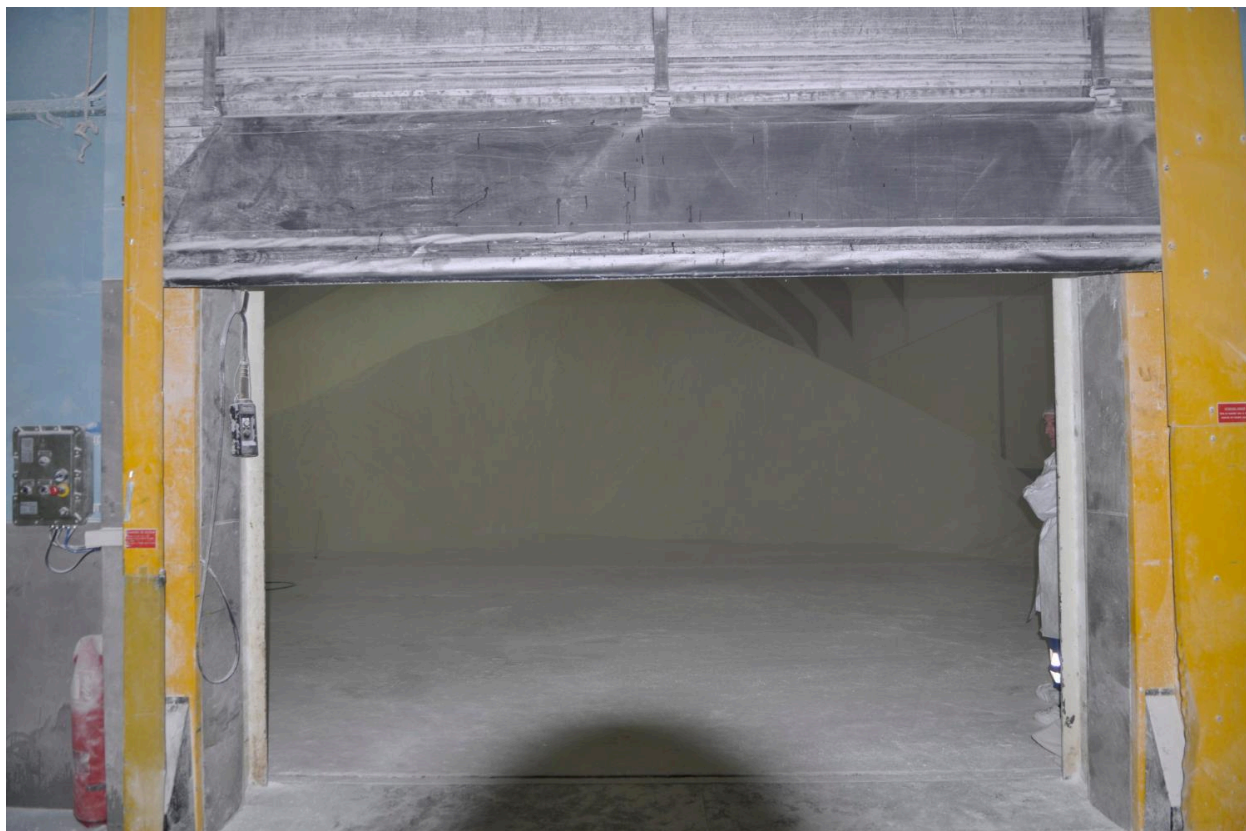
Détail silo à sucres
