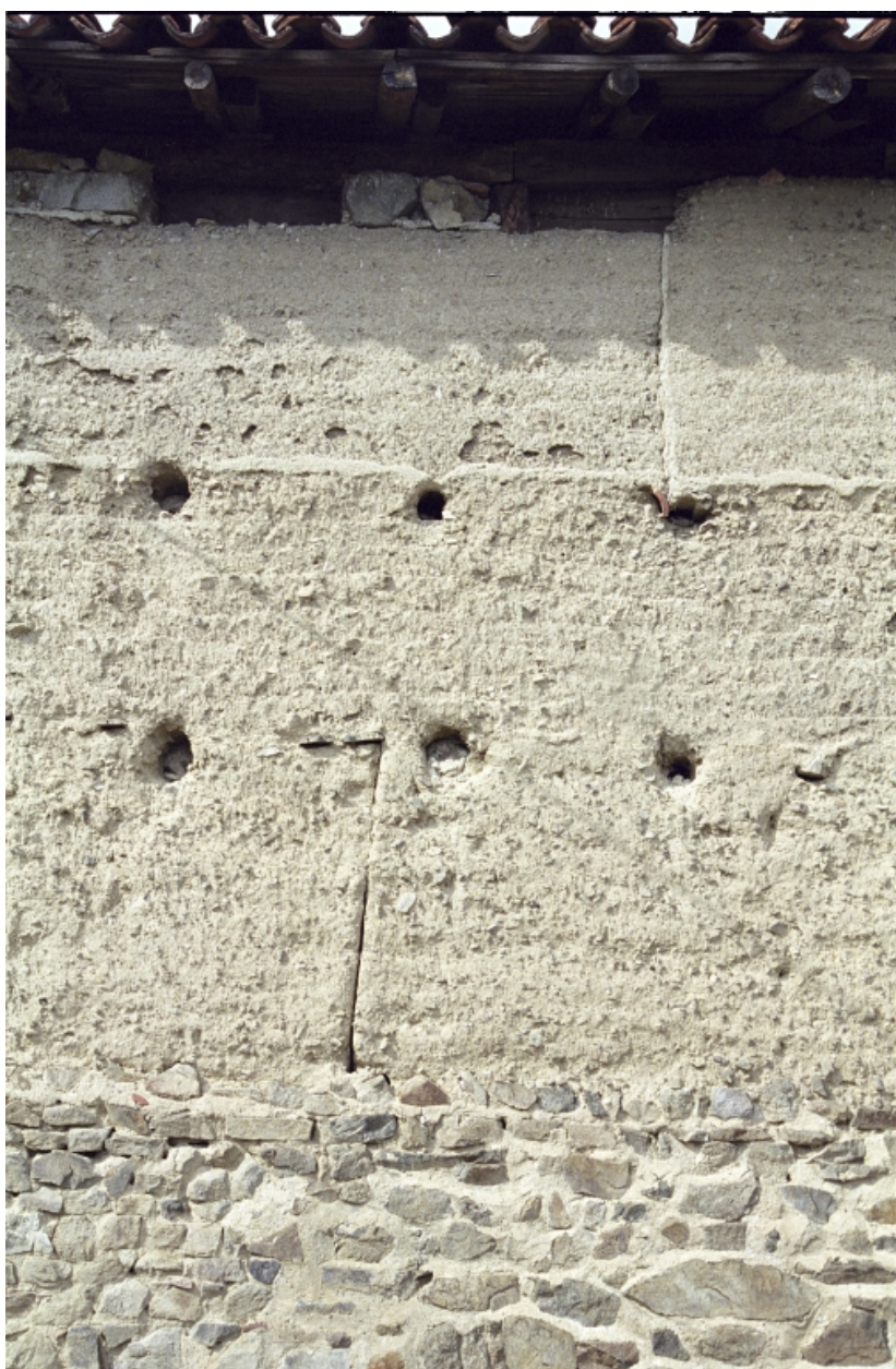
Saint-Sixte, le bourg, ferme (1987 A1 85). Elévation postérieure, détail (milieu 19e siècle).
