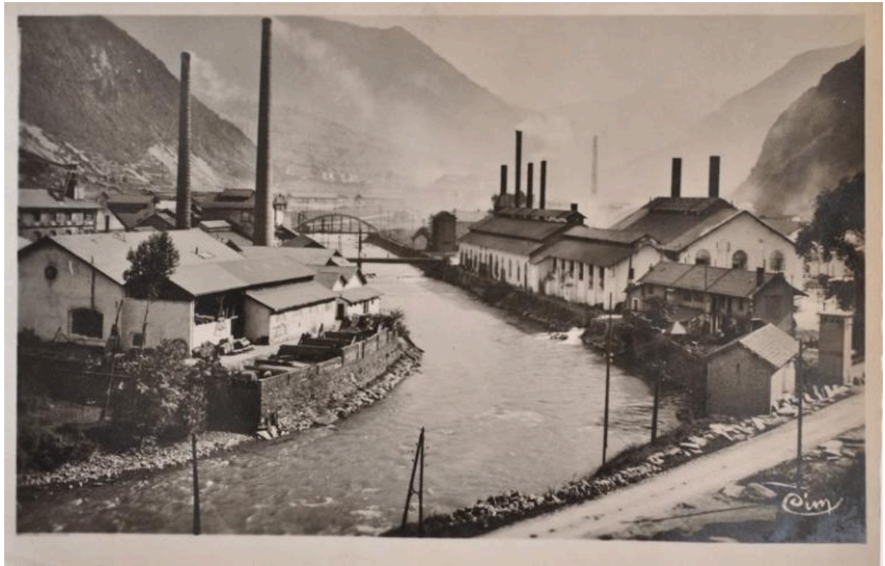
A gauche (rive droite), usine de la Société Française des produits azotés. A droite (rive gauche), usine de carbure de calcium et d'électrode (© Collection particulière M.-A. Podevin).
