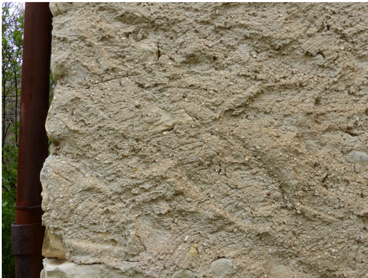
Elévation sud, enduit rustique.
