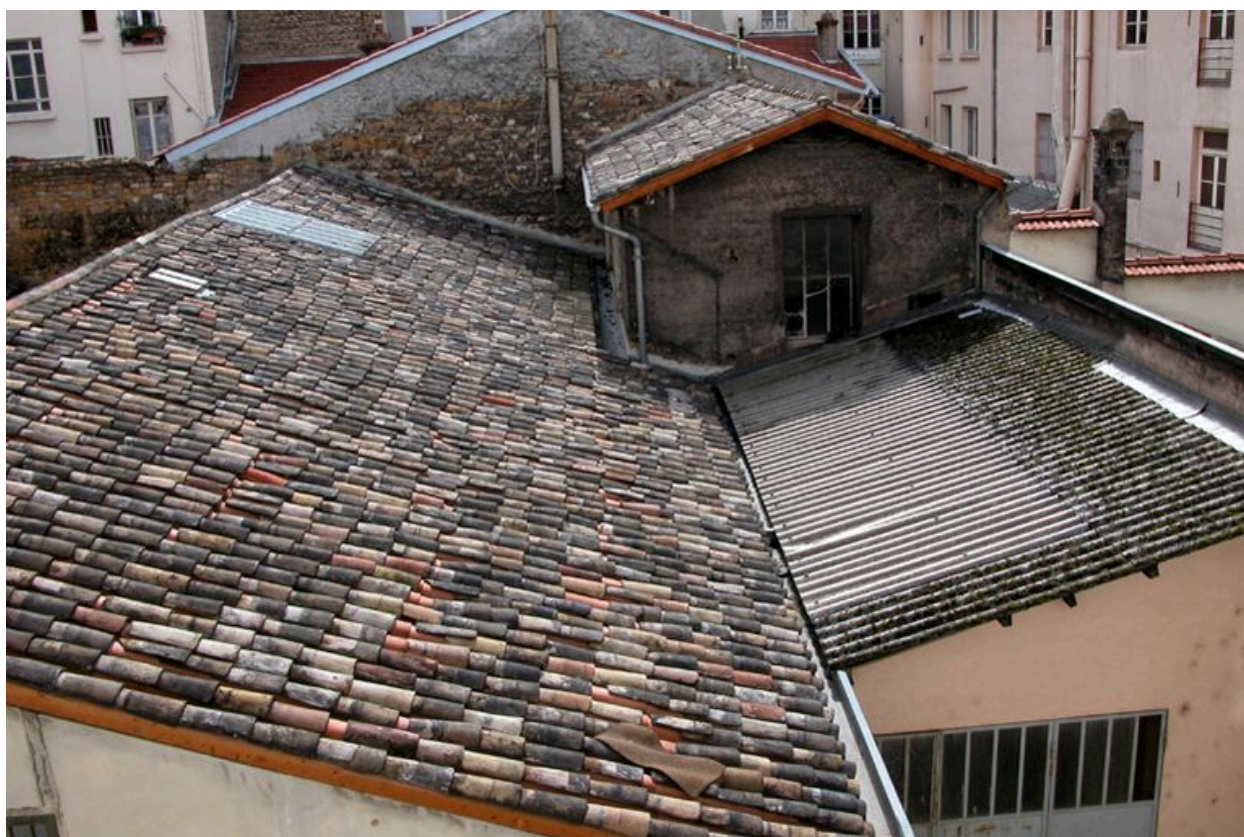
Vue des toits des bâtiments sur cour
