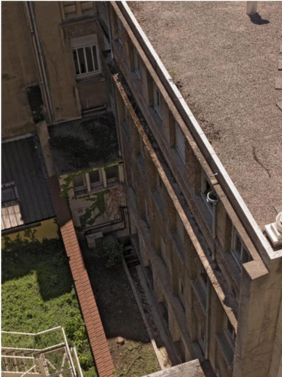
Bâtiment Leperc, élévation postérieure, depuis le haut
