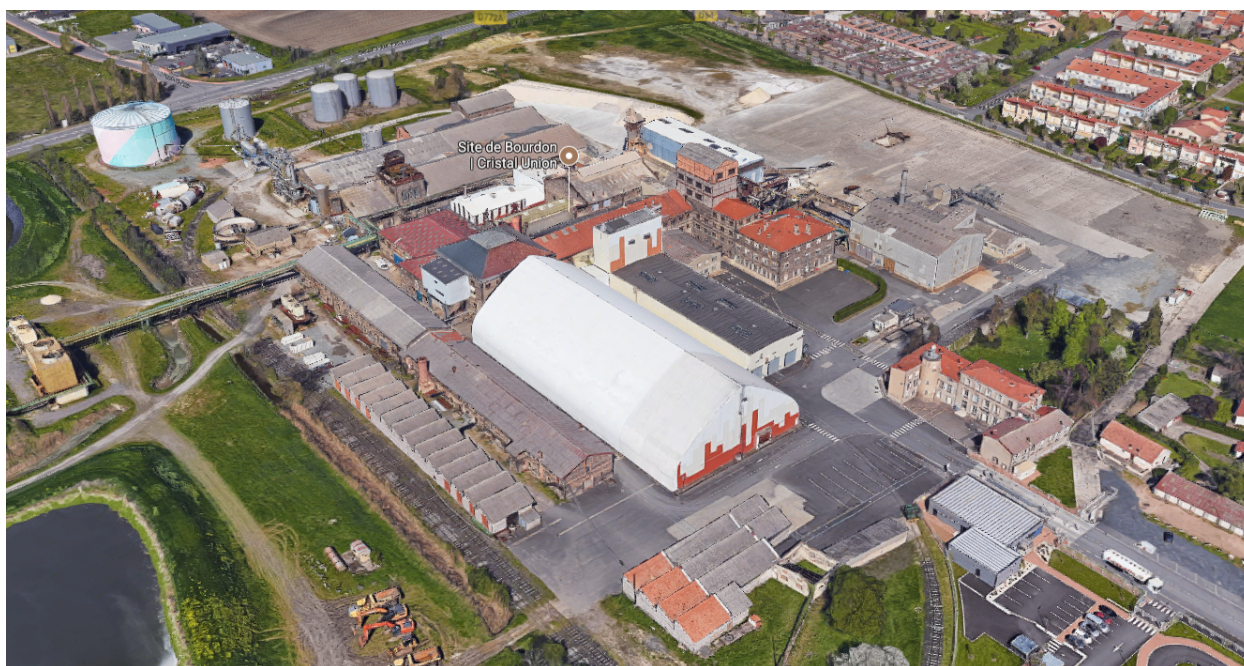
Vue Google zénithale du site de la sucrerie Bourdon-Cristal-Union
