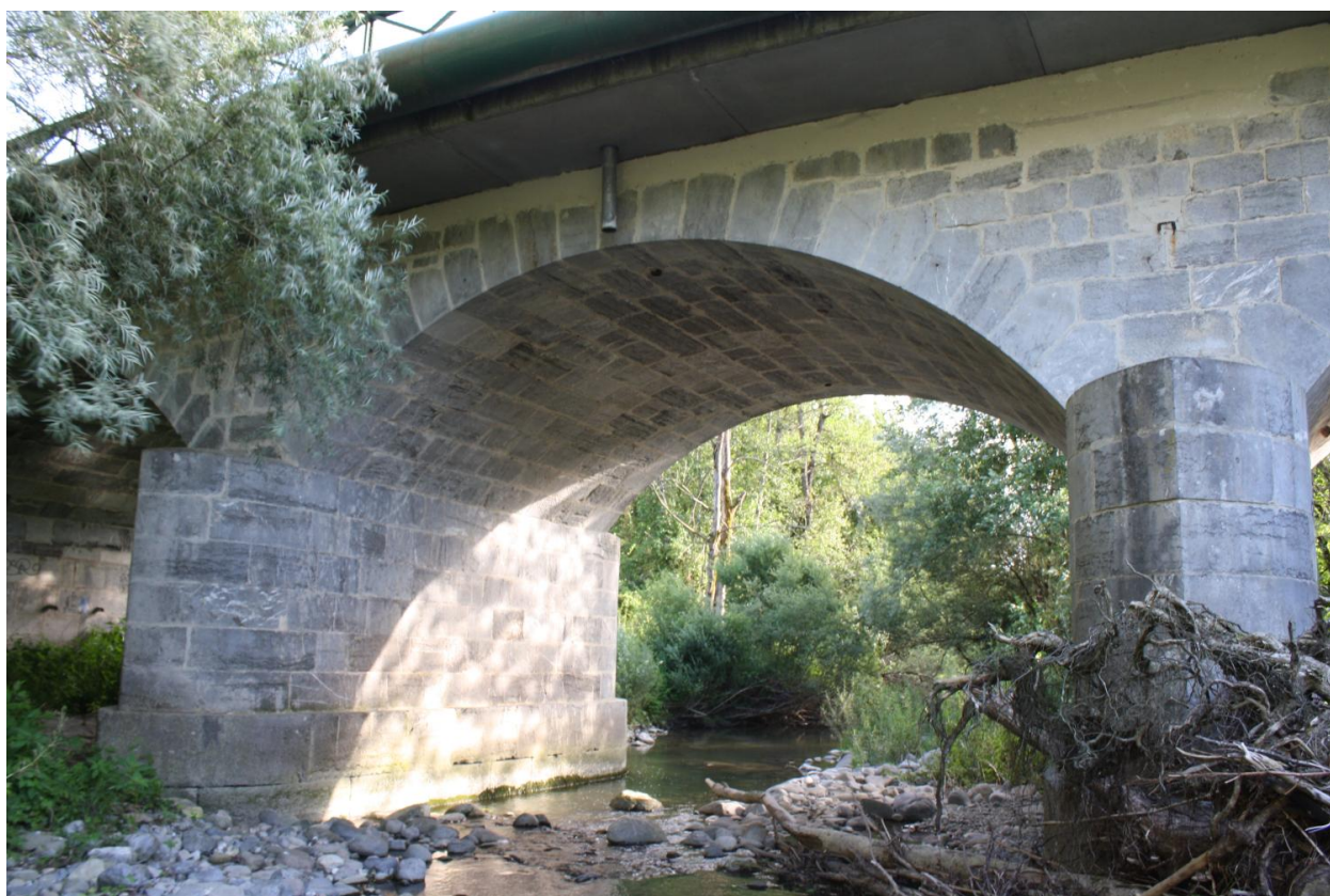
Pont du Plot, détails voute centrale et plies
