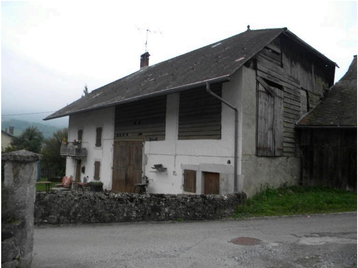
Vue de trois-quarts nord-est.
