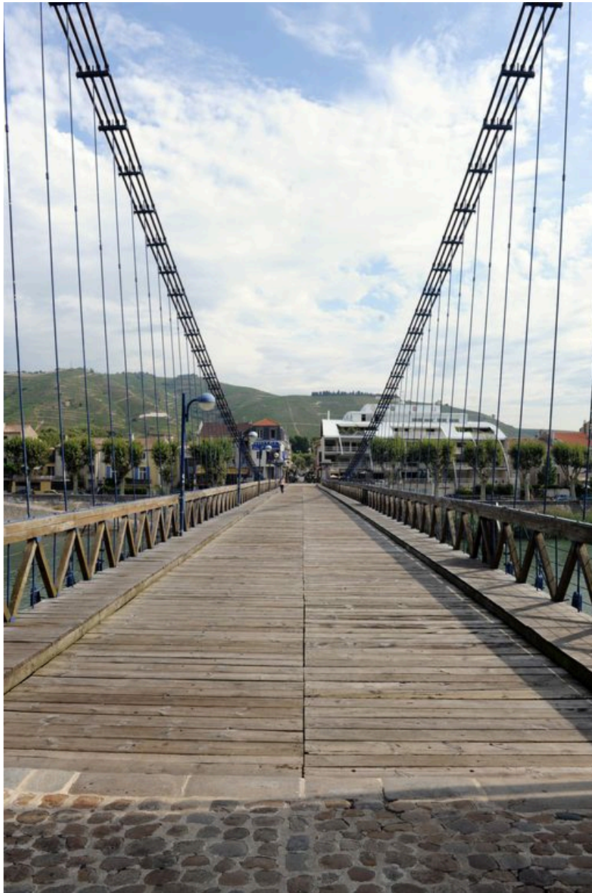
Vue partielle, de dessus, travée gauche, voie piétonne, suspendes (depuis le dessous de la pile centrale)
