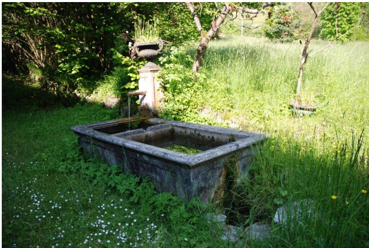
Vue du bassin (fontaine-abreuvoir).
