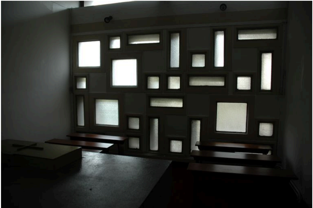
Claustra formant la façade de la chapelle de semaine
