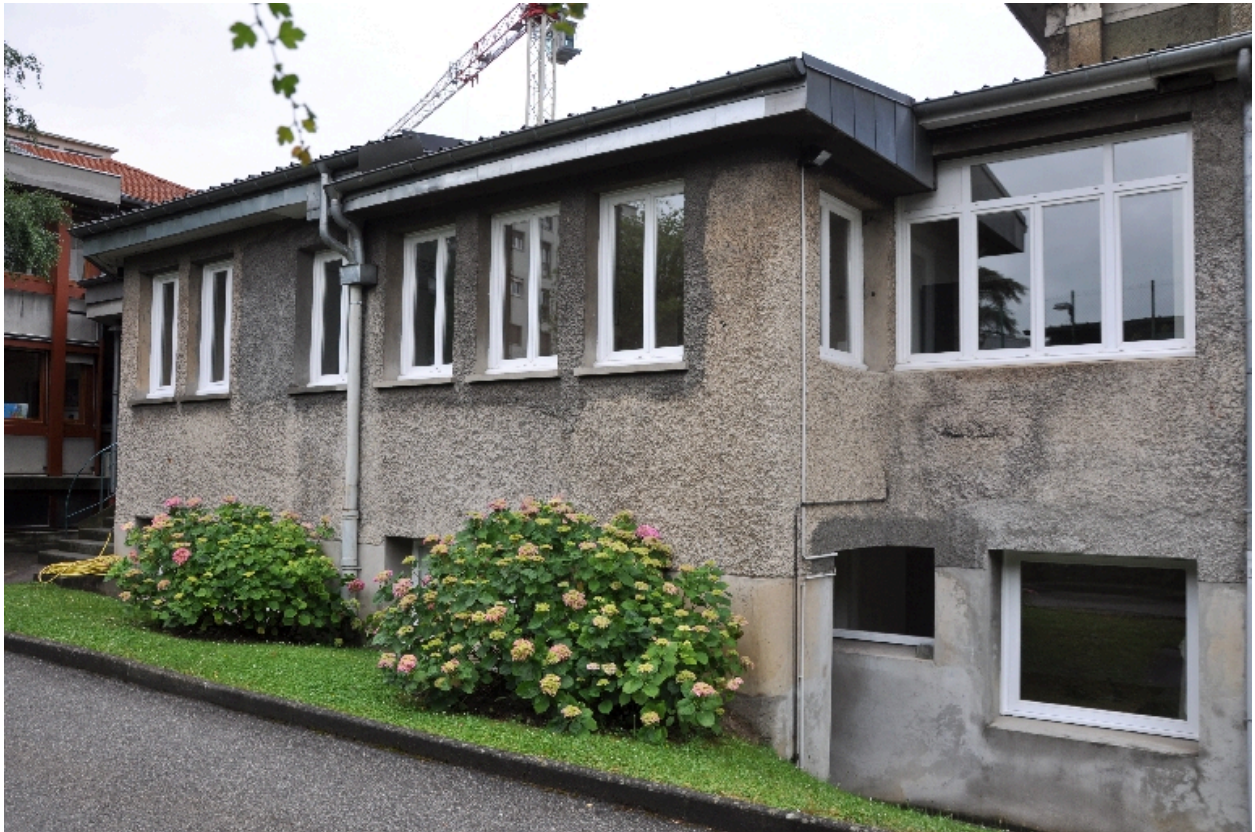
Façade nord du siège social
