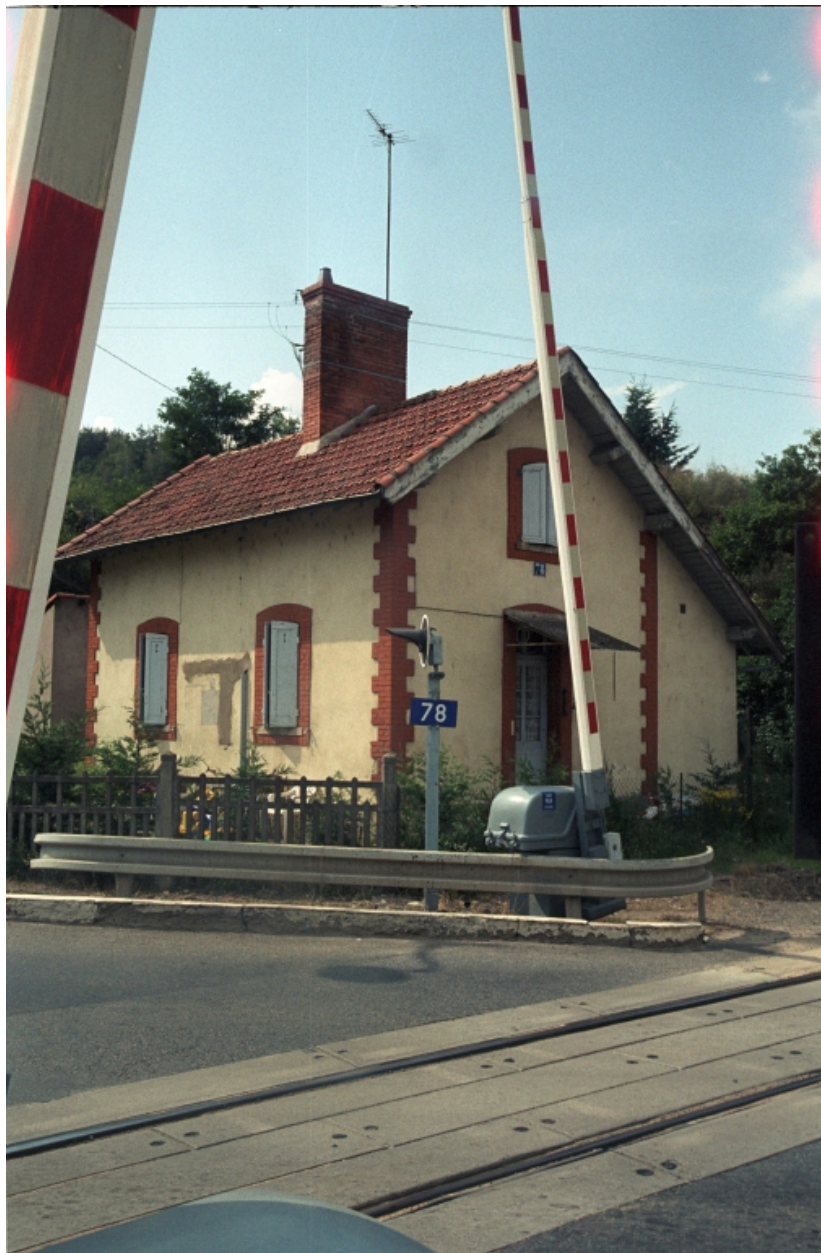
Leigneux, Chozieux, 1987 A3 1351. Maison de garde barrière (à l'entrée de la ville de Boën).
