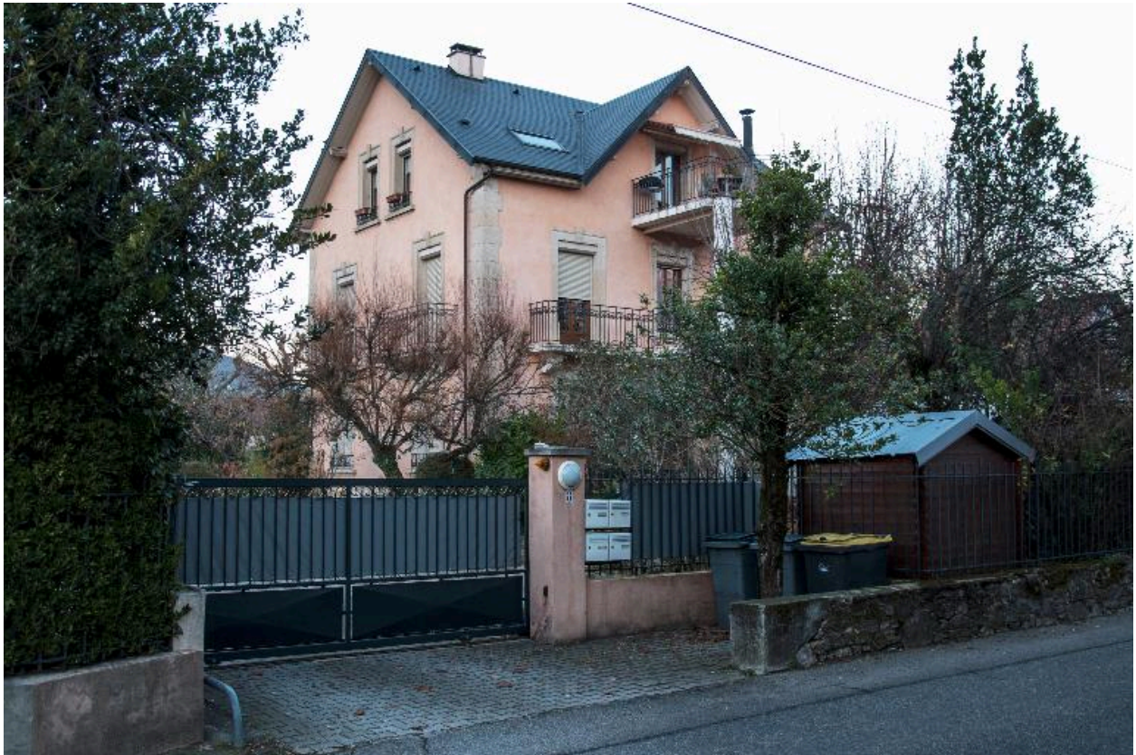
Façade sud et pignon ouest
