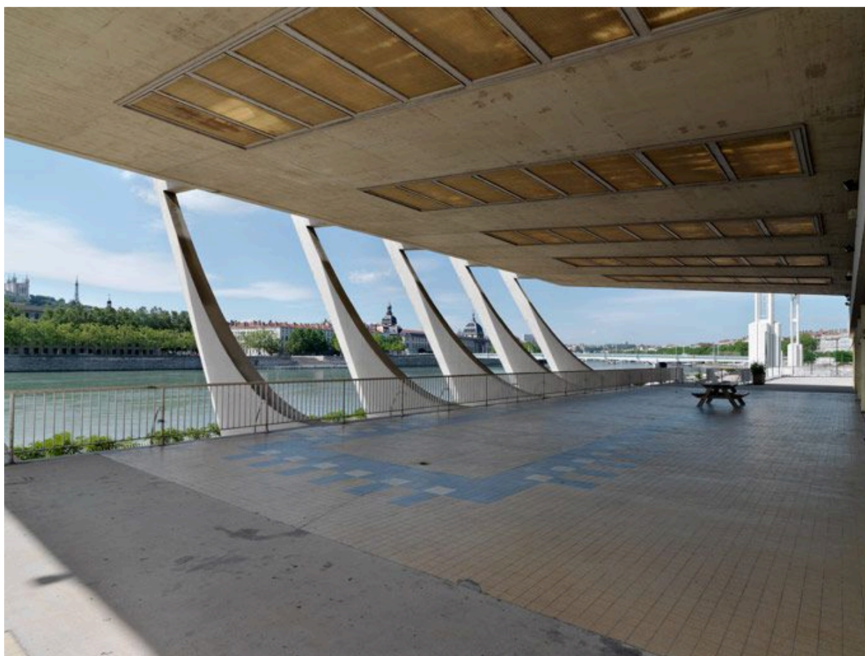
Vue de la terrasse (niveau du quai, état en juin 2012).
