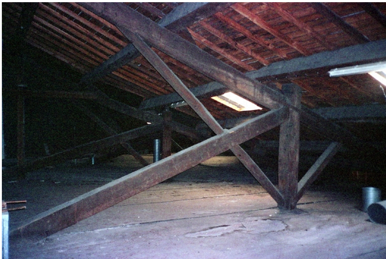
Vue de la charpente
