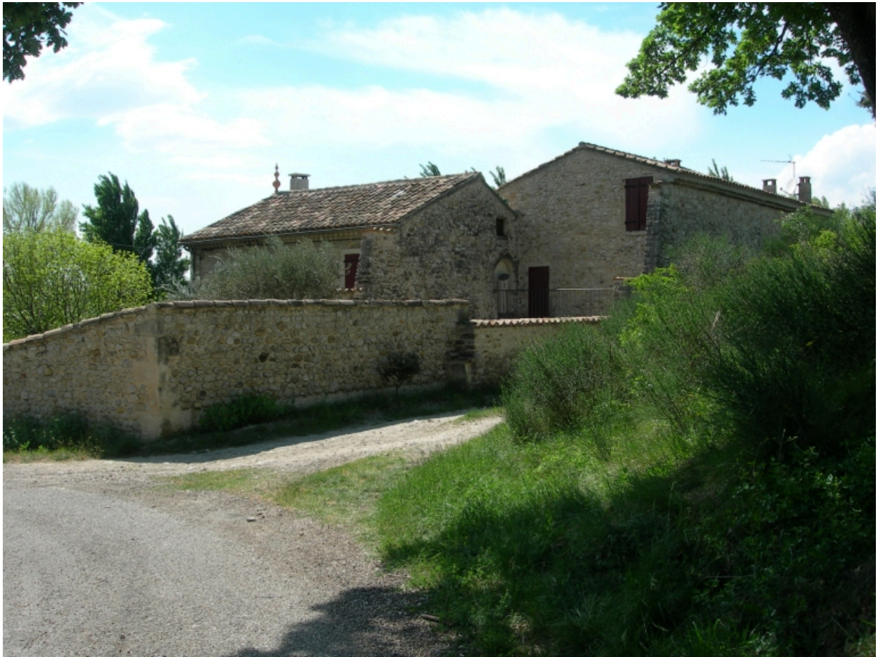
Vue générale du bâtiment en arrivant par le chemin du Moulin, au nord-est.
