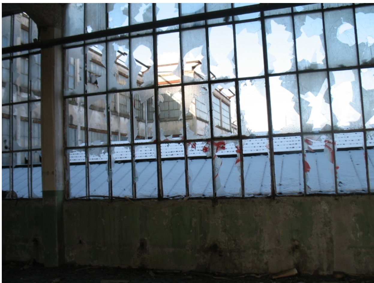
Baie du 1er étage
