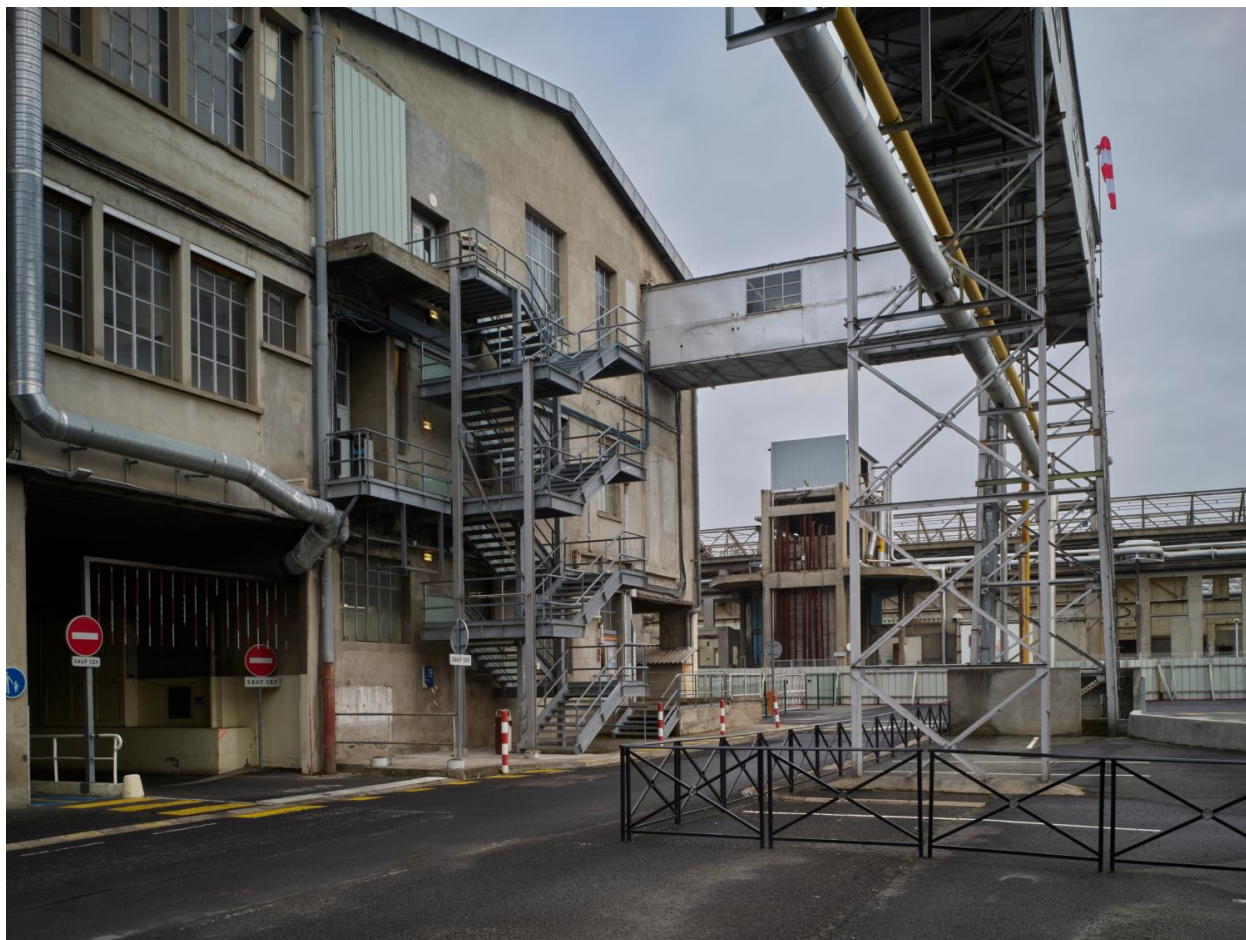
La rue de Surat en direction du sud : passerelle technique entre la chaufferie B40 et le bâtiment T50 ; à l'arrière-plan, l'ancien atelier O23.
