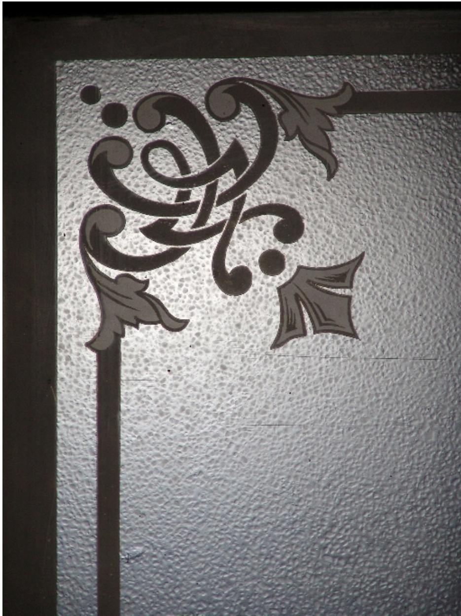
Rez-de-chaussée nord : détail d'une fenêtre des sanitaires
