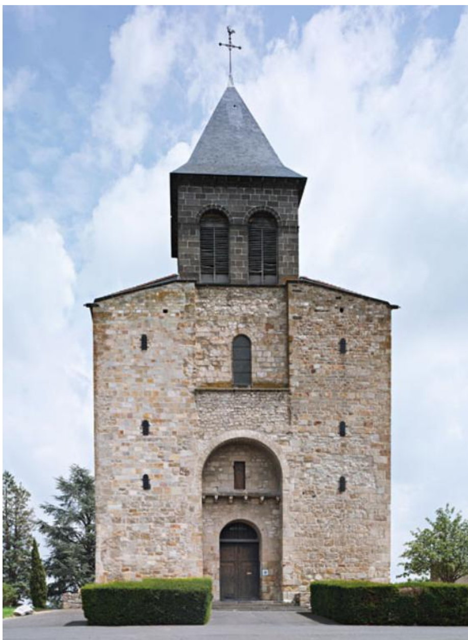
Vue générale de la façade occidentale.
