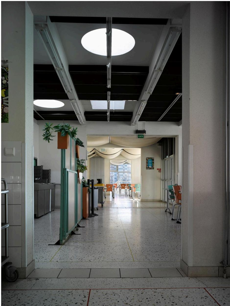
Dans la cantine. Oculi zénithaux ménagés dans la couverture destinés à donner de la lumière. Les ouvertures zénithales de plan carré peuvent être ouvertes grâce à un mécanisme en métal.
