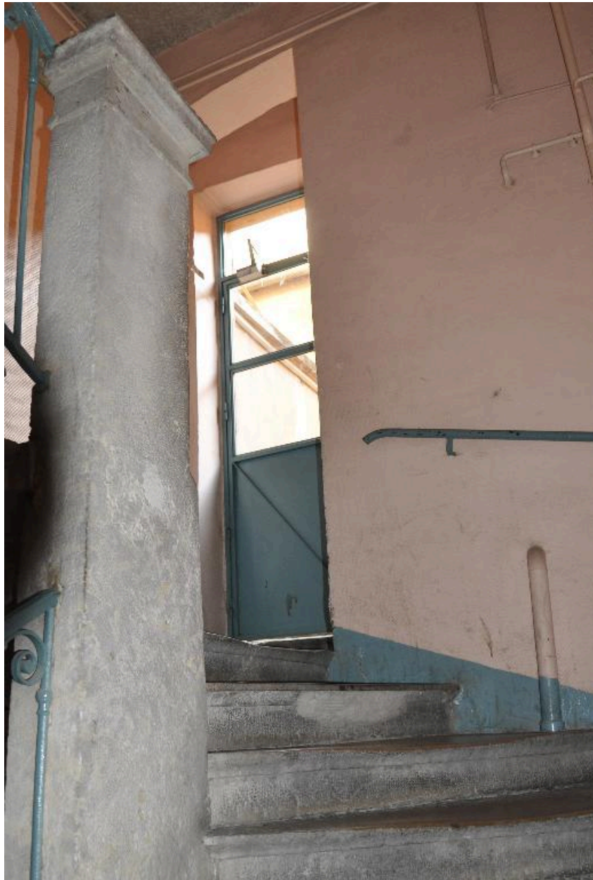
Vue intérieure : premier repos de l'escalier, accès au bâtiment sur cour
