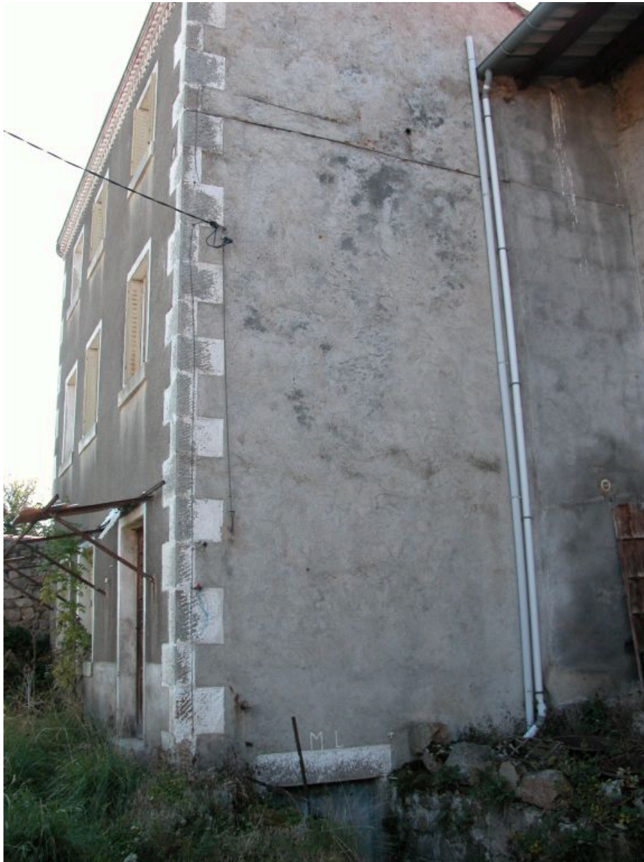
Elévation du logis 3, depuis le nord-est (on distingue la porte de la cave sur le mur nord).
