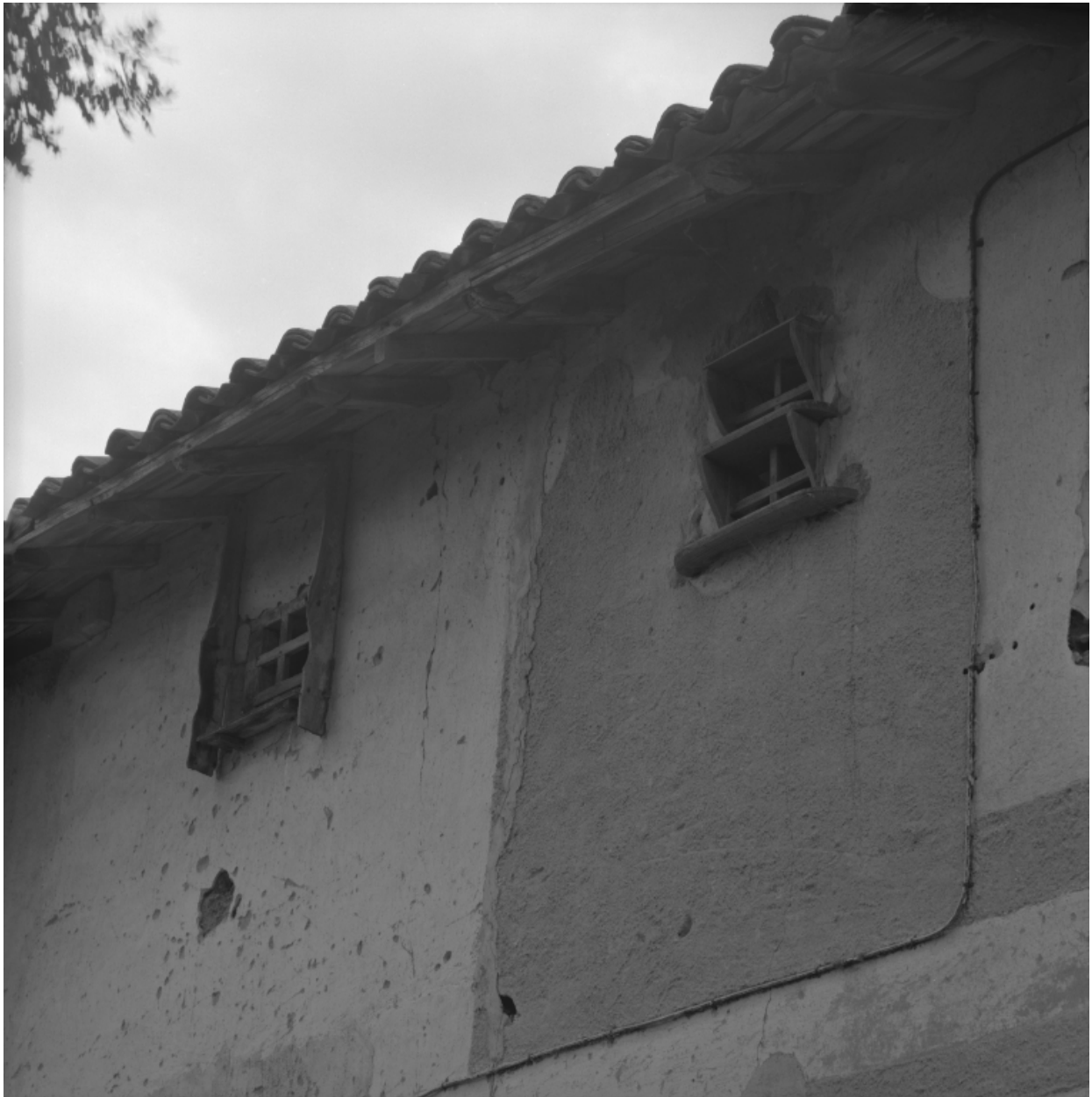
Premier ensemble. Bâtiment sud-est : détail des fuies.
