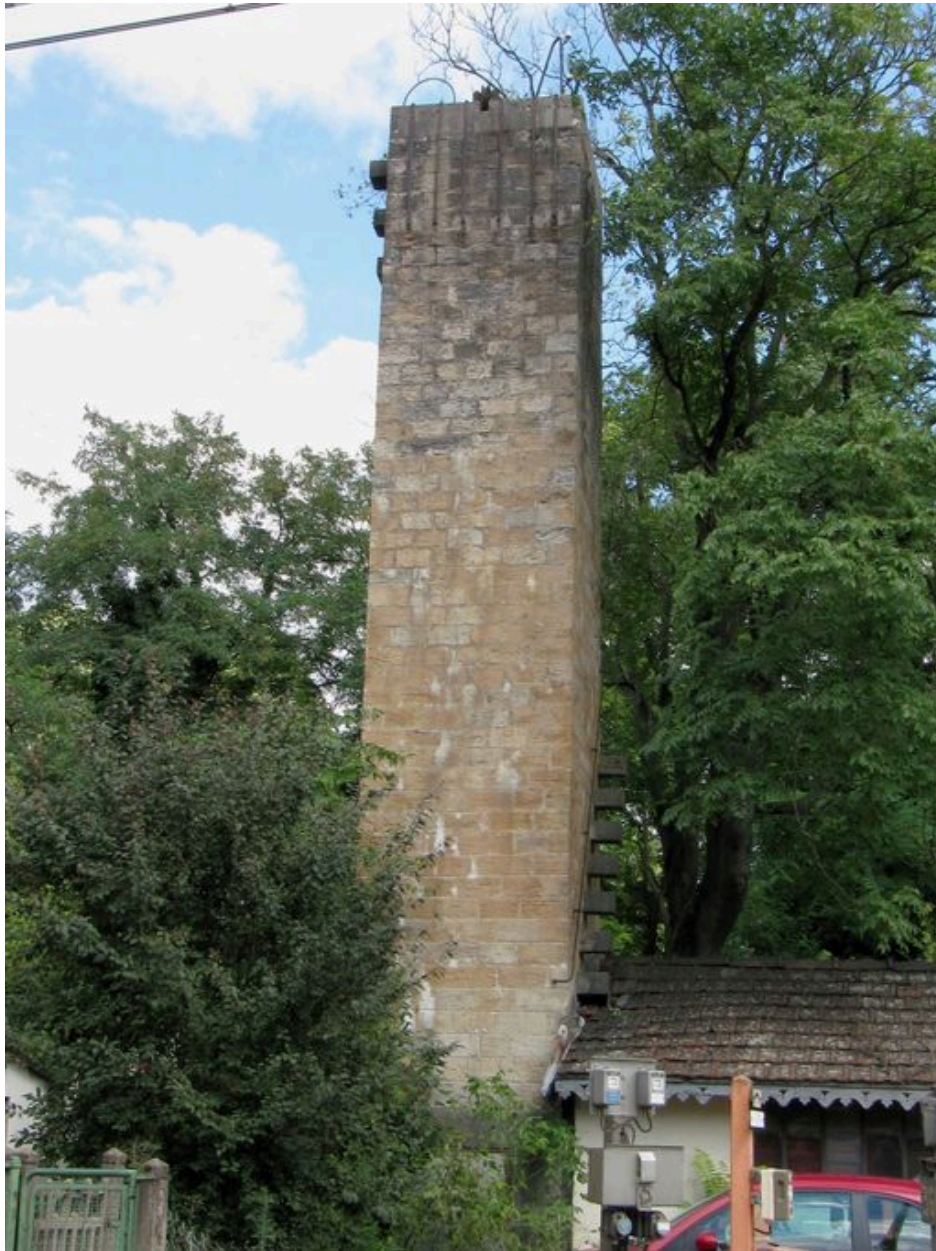
Pile droite, vue générale (depuis l'ouest)
