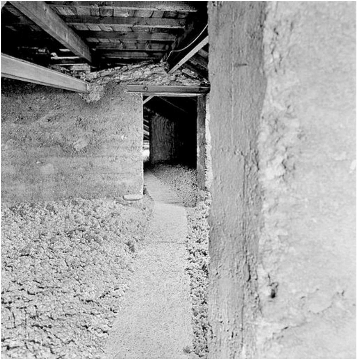
Charpente métallique dans l'angle des corps de bâtiments rues Gilbert-Dru et Saint-Michel
