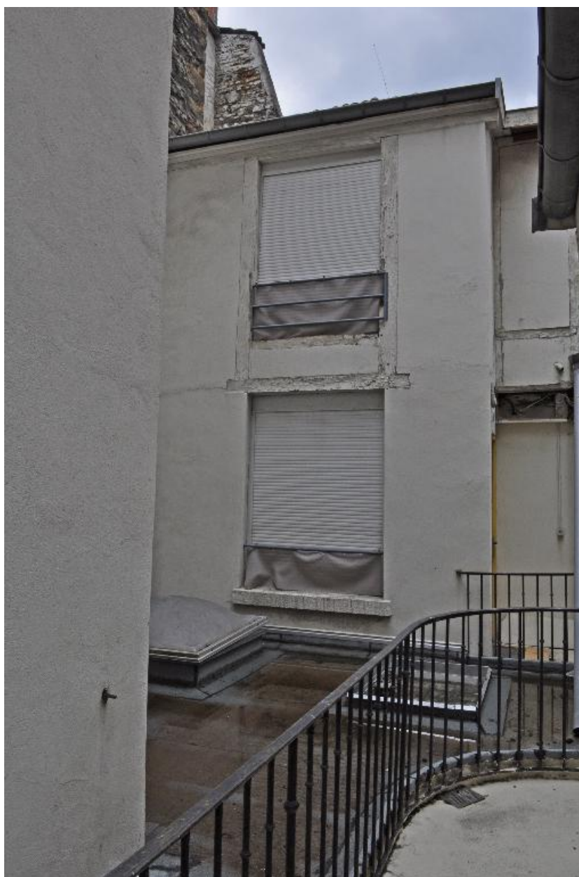
Bâtiment sur cour en pan-de-bois, adossé au n°7 rue Pasteur, desserte par coursière
