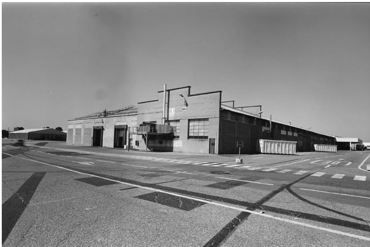
CDIPR : bâtiment BE3.
