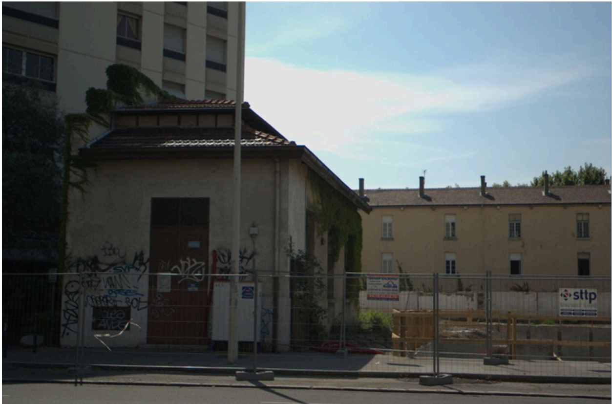
Vue d'ensemble ouest du bâtiment conservé
