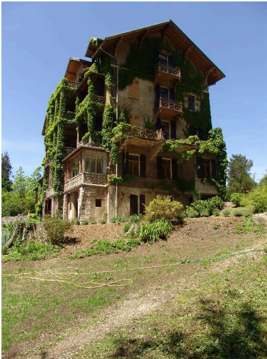
Logement des soeurs : pignon sud-est et façade principale
