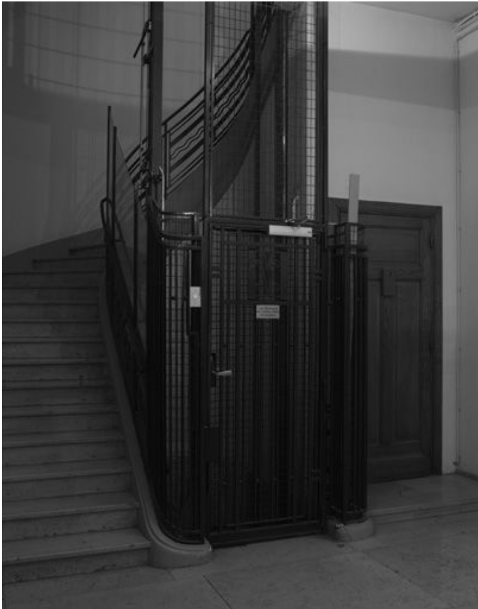
Escalier et ascenseur non éclairé vus depuis le palier du rez-de-chaussée
