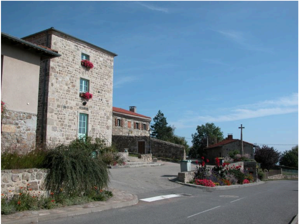
Bourg (le). Vue d'ensemble de la mairie et de la D113, partie est du bourg.
