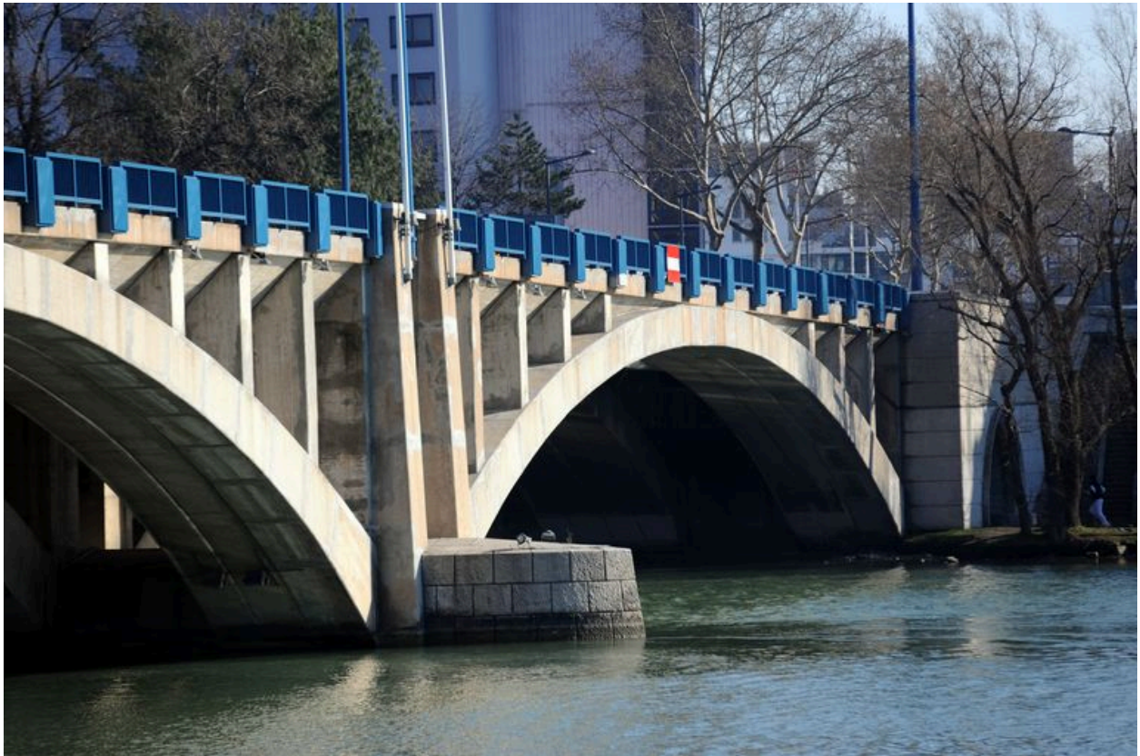
Vue partielle, travée et culée gauche, face aval (depuis la rive droite)
