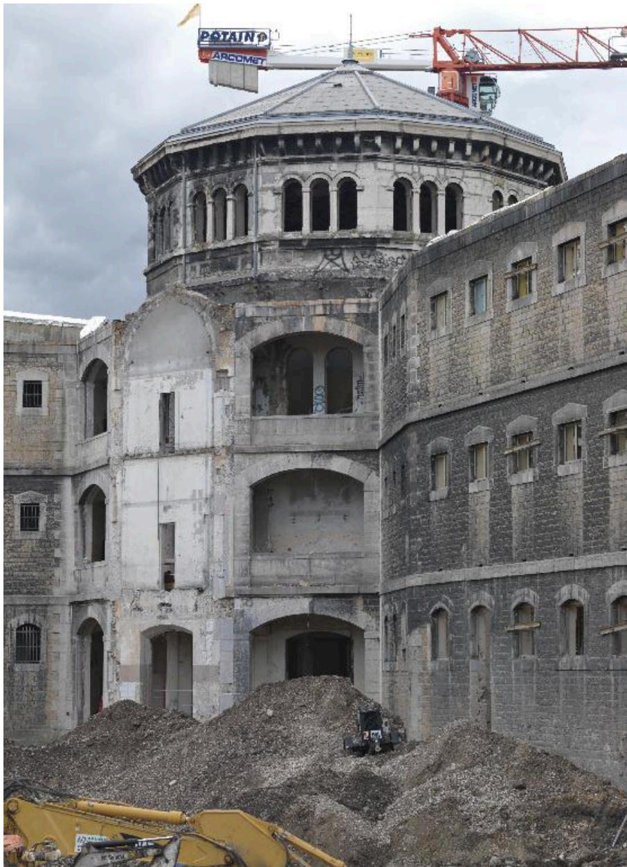
Etat en juin 2013 : le bâtiment central
