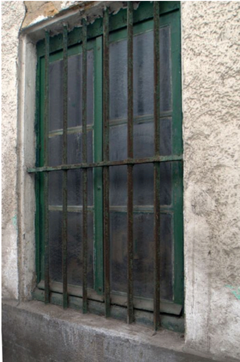
Fenêtre du rez-de-chaussée et sa grille de fermeture
