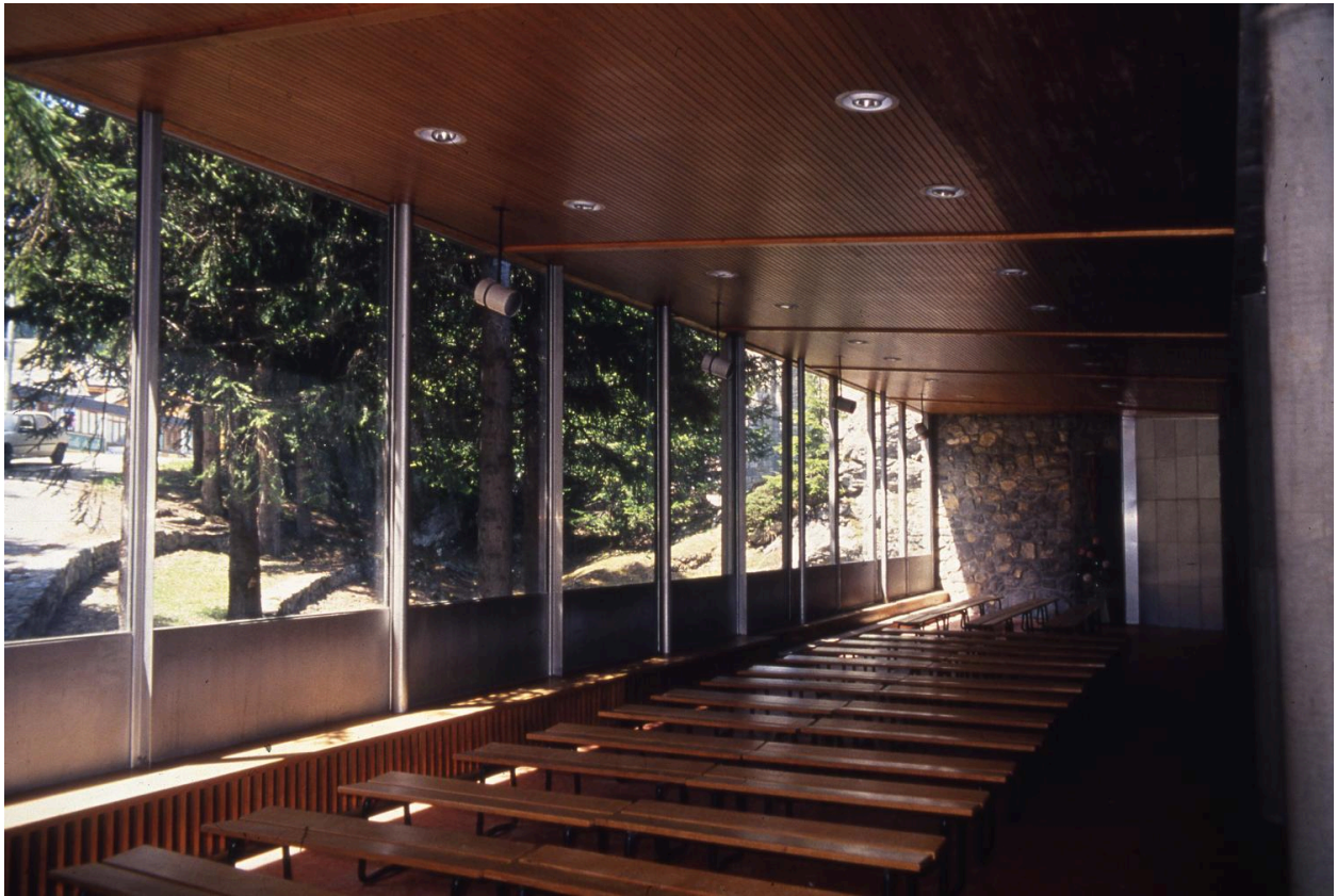
Elévation intérieure sud de la nef
