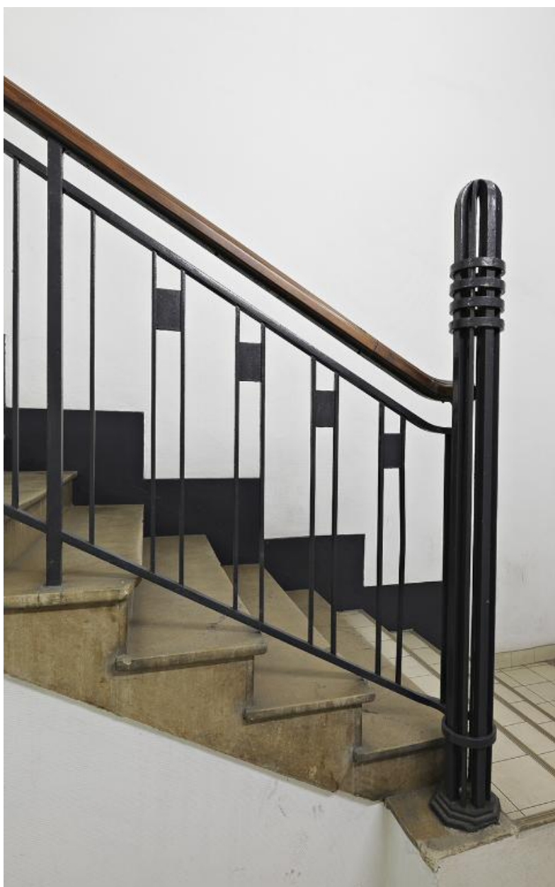
Escalier E : détail de la rampe
