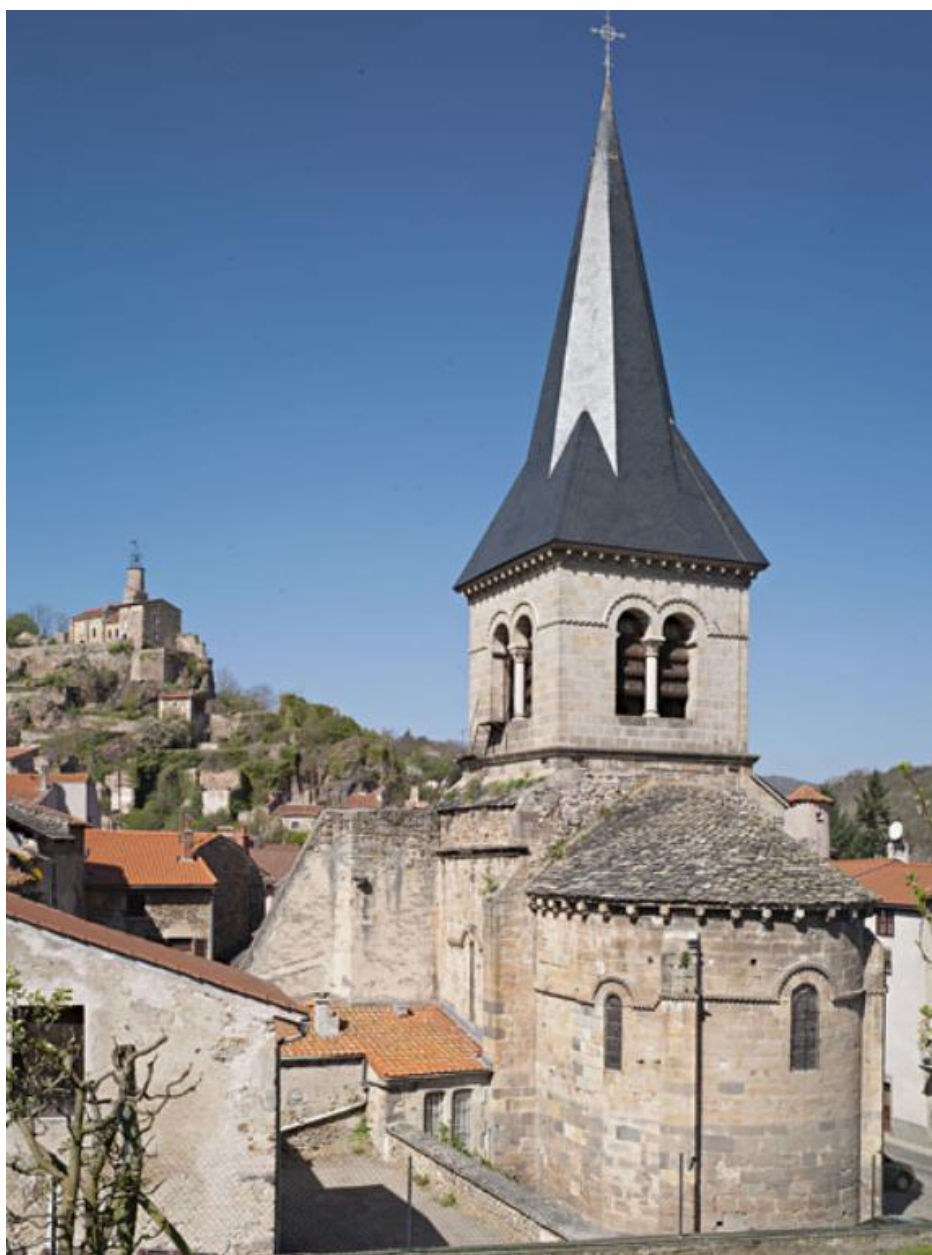
Vue de l'angle sud -est
