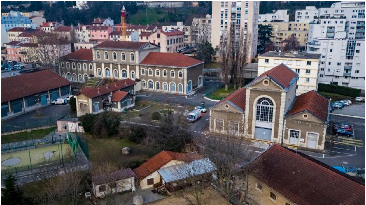
Vue de l'usine des eaux (drône)
