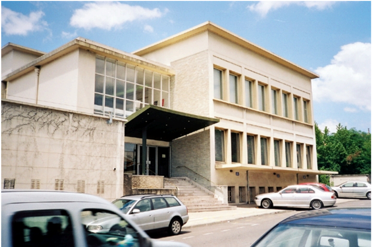
Batiment administratif, façade est
