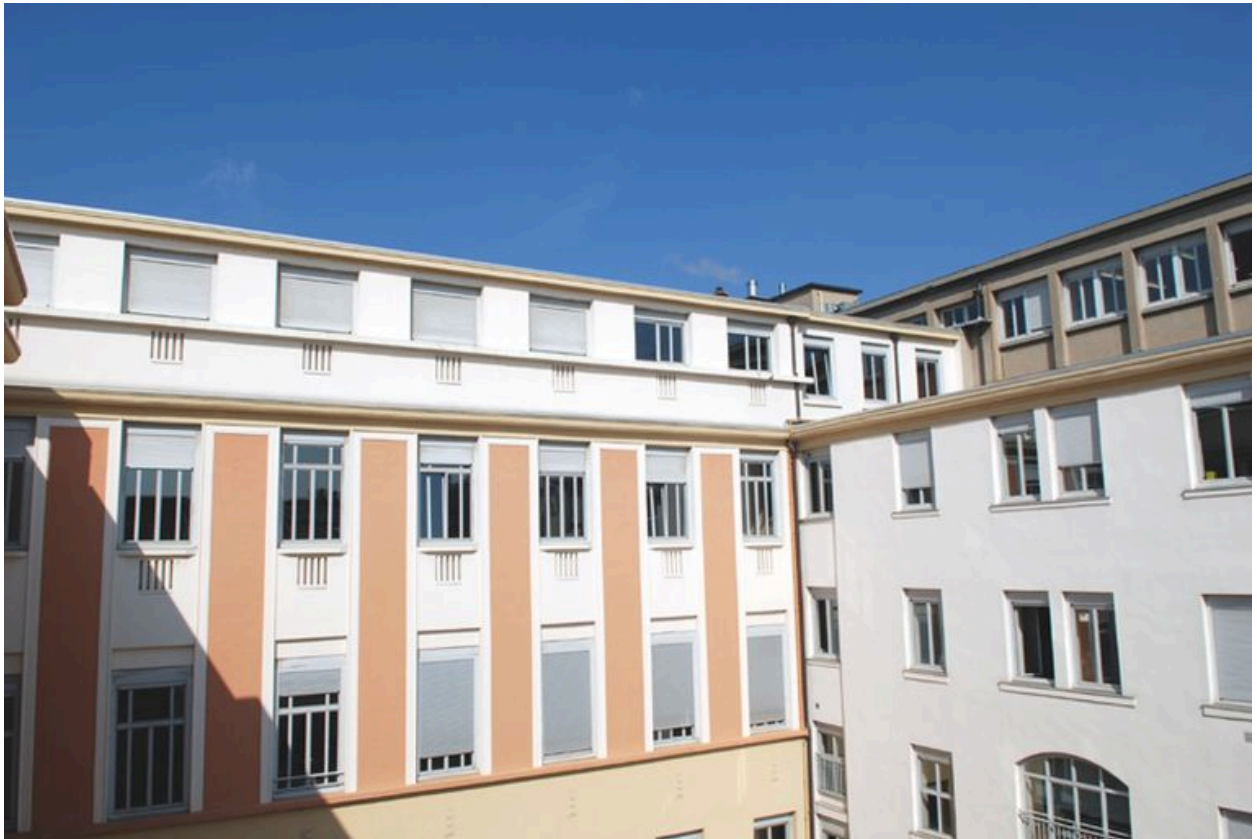
Cour intérieure, derniers niveaux des élévations nord et ouest
