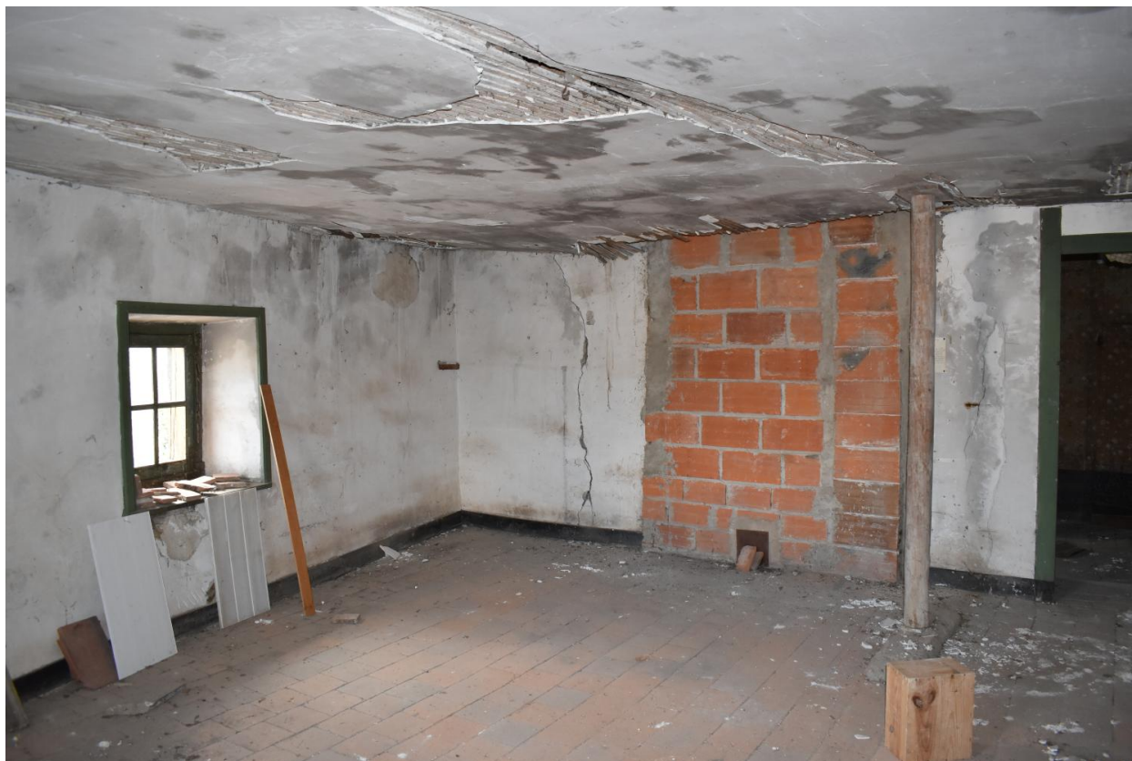
étage de comble. Vue d'ensemble de l'espace E vers le sud-ouest.
