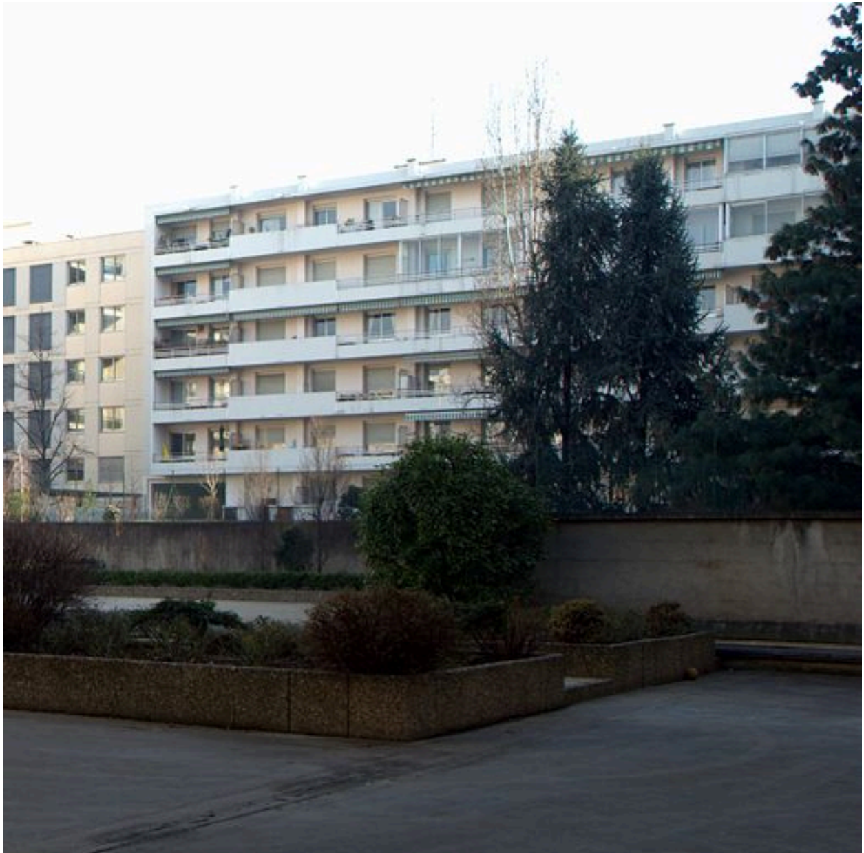
Elévation postérieure, vue partielle du côté nord
