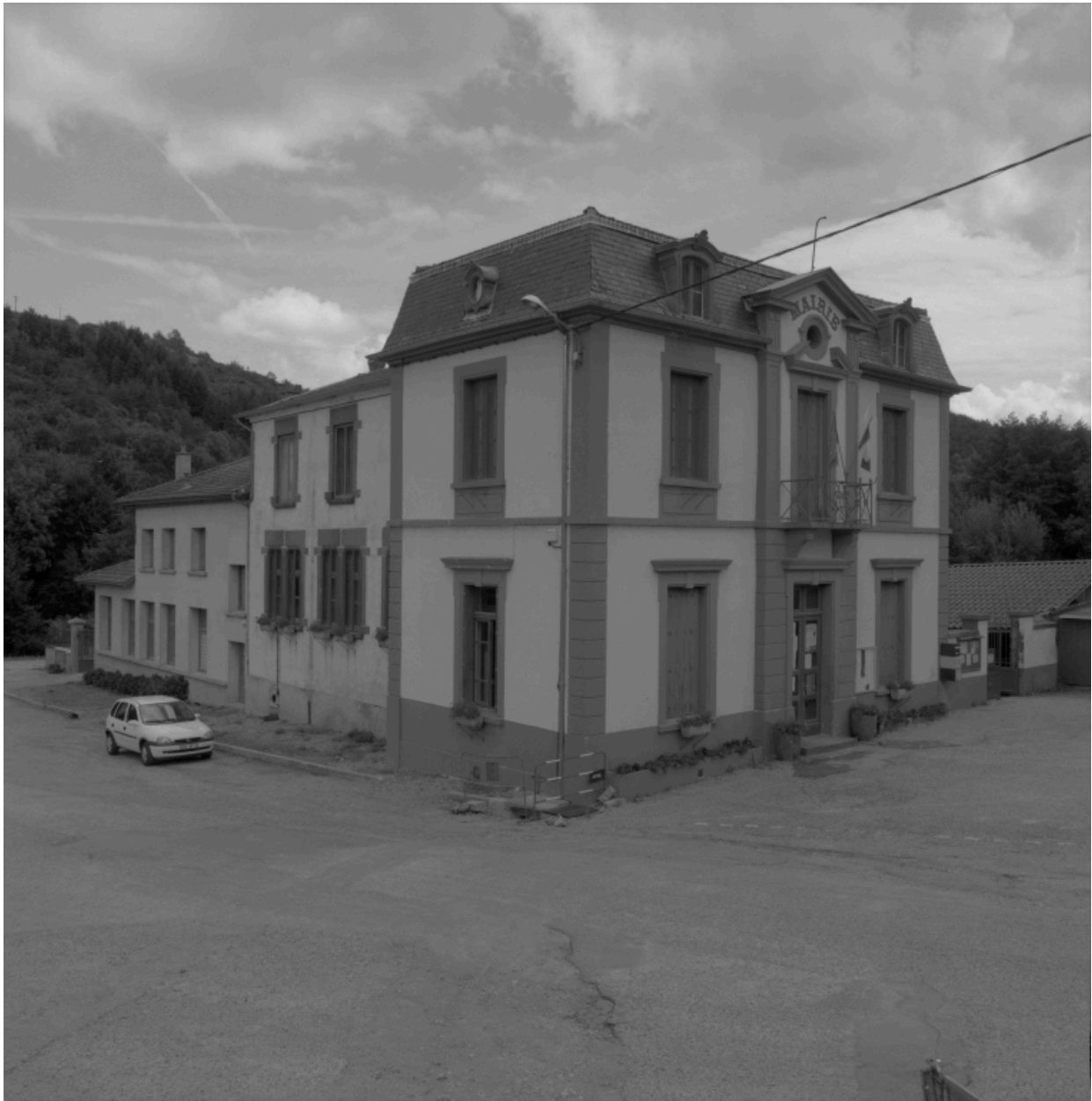
Vue d'ensemble de trois-quarts avant gauche.
