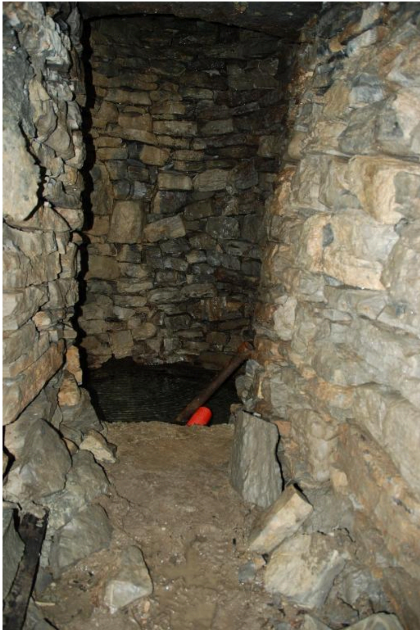
Prise d'eau aux Arbets (alpage de l'Arclusaz) : le couloir, arrivée à la chambre de captage.
